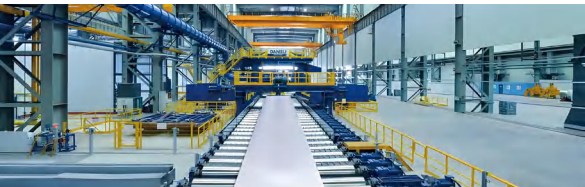
金属板材生产流水线
